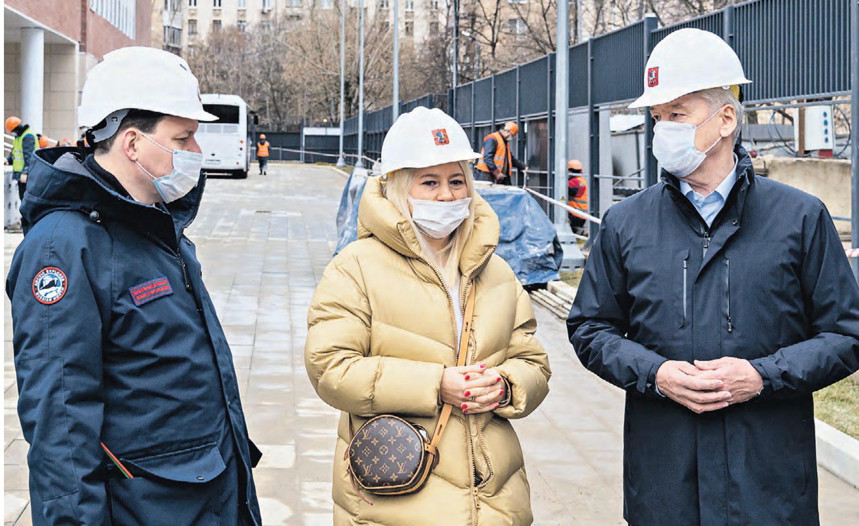
Вчера 11:05 Мэр Москвы Сергей Собянин (справа), генеральный директор компании-подрядчика Илья Зюбин и директор школы № 1252 Ирина Анурова осматривали ход строительства нового учебного корпуса в районе Сокол. Школа примет старшекласников в сентябре следующего года
