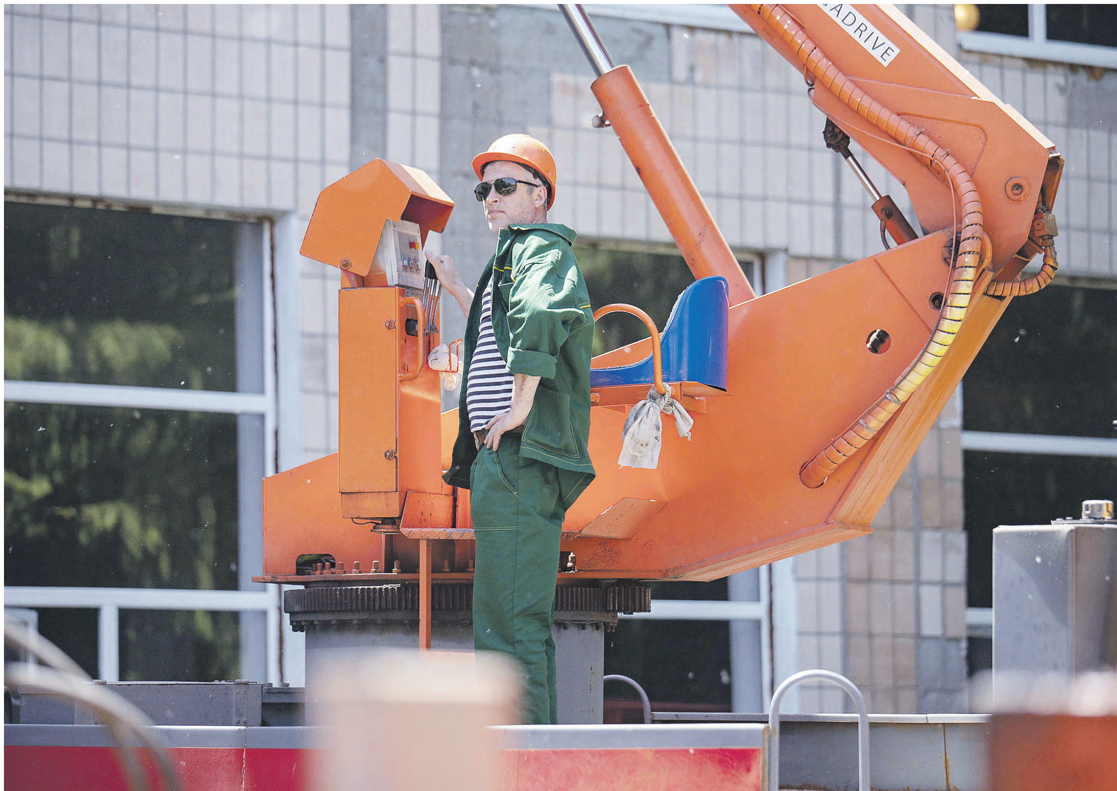
3 июня 2022 года. Сотрудник одного из подразделений Комплекса городского хозяйства Москвы проводит работы по восстановлению одной из школ в Луганске
