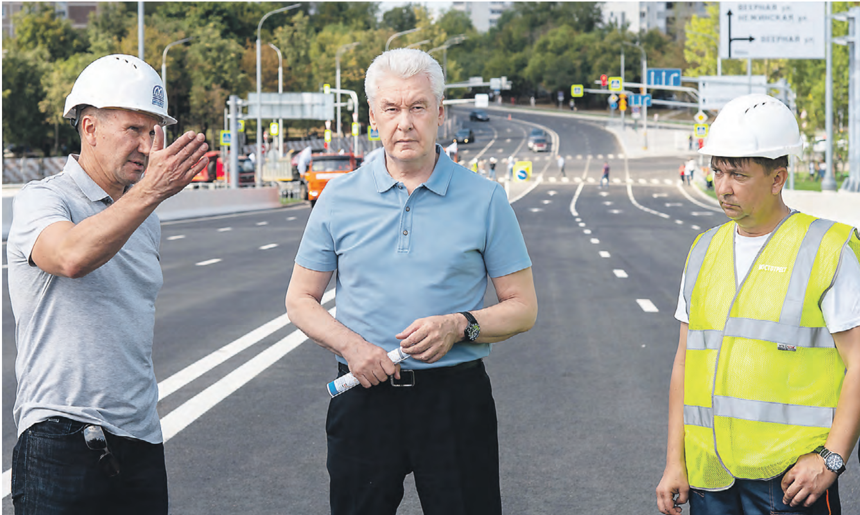
Вчера 12:40 Управляющий проектом строительства Виктор Коротин (слева) рассказал мэру Москвы Сергею Собянину (в центре) о преимуществах, которые получили водители с открытием путепровода. У них появился удобный выезд на южный дублер Кутузовского проспекта, который сейчас называется проспект Генерала Дорохова
