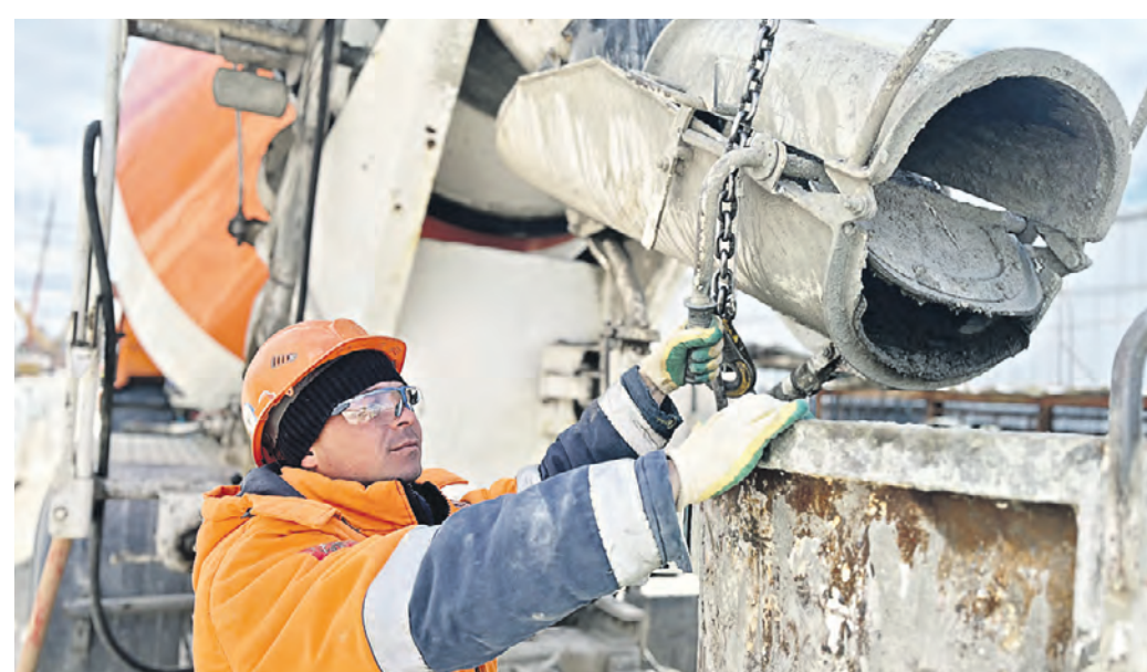
6 мая 2023 года. Бетонщик Александр Иванов принимает раствор. Работы идут на продлении Солнцевской линии метро, которая дойдет до аэропорта Внуково
