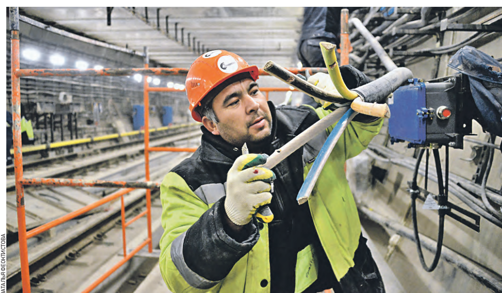
19 ноября 2022 года. Электромонтажник Евгений Вожнов проверяет кабели на станции «Печатники» Большого кольца метро
