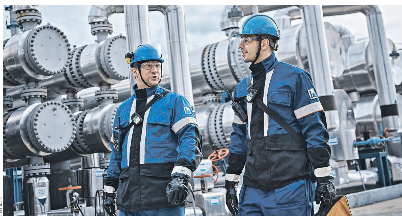
Операторы технологических установок Московского НПЗ Сергей Семенов (справа) и Александр Незнанов осматривают оборудование
