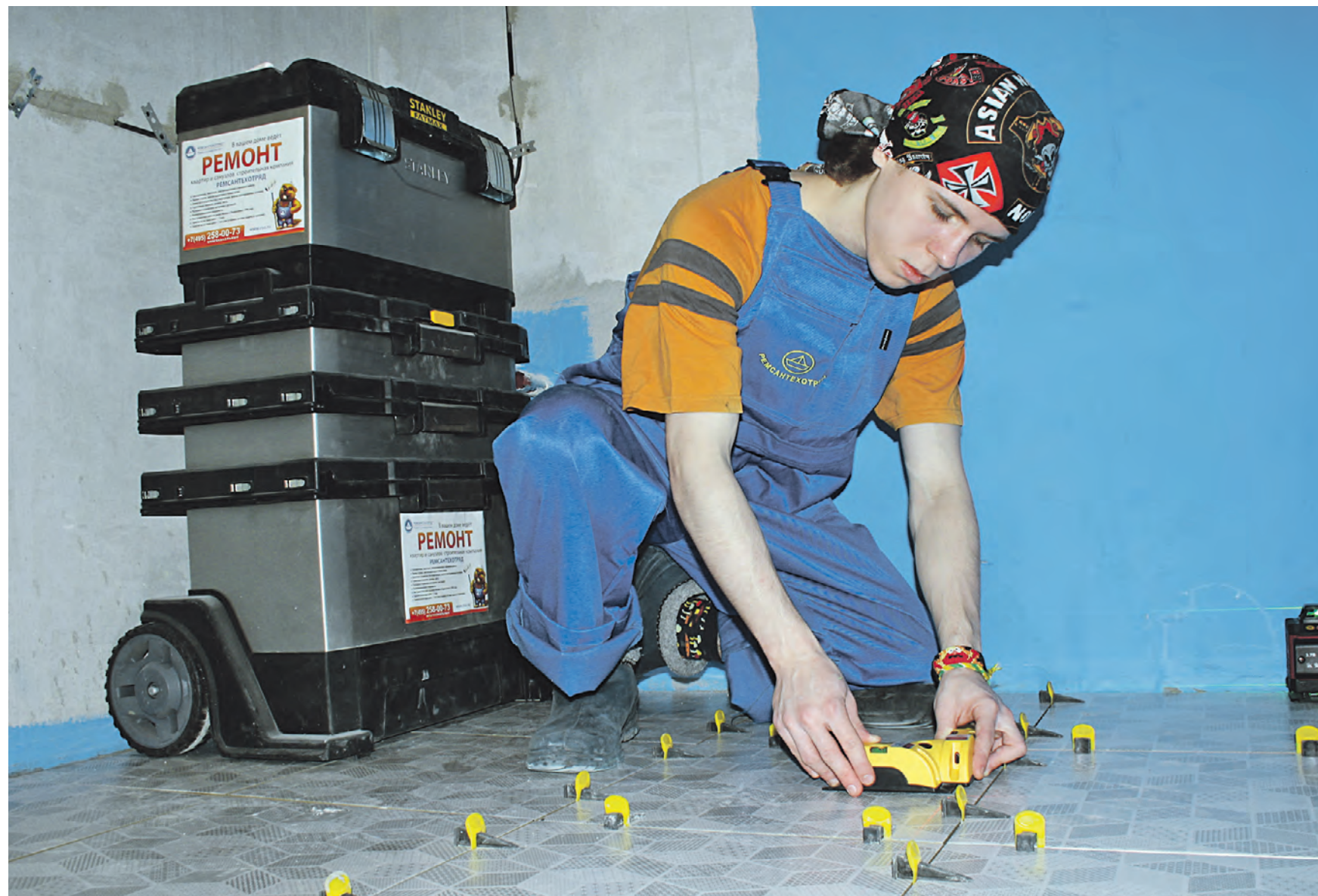
25 марта. Ученик-стажер компании «РемСантехОтряд» Сергей Петров на практическом занятии по укладке напольного покрытия
