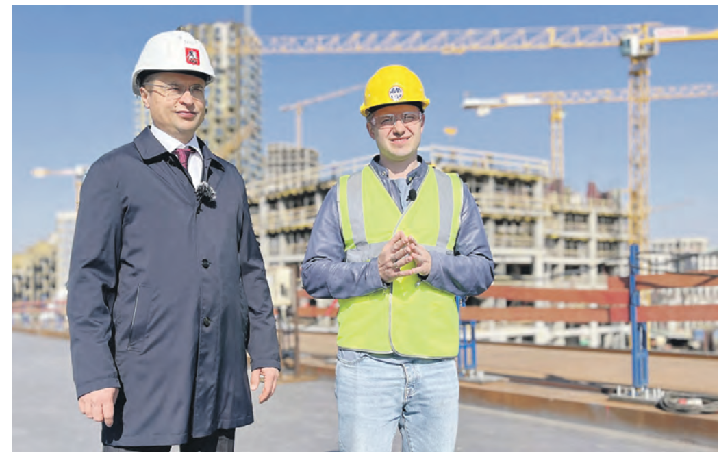
Вчера 9:16 Глава Департамента строительства Рафик Загрудинов (слева) и корреспондент одного из телеканалов Андрей Шляпников прошли по строящемуся мосту через затон Новинки
