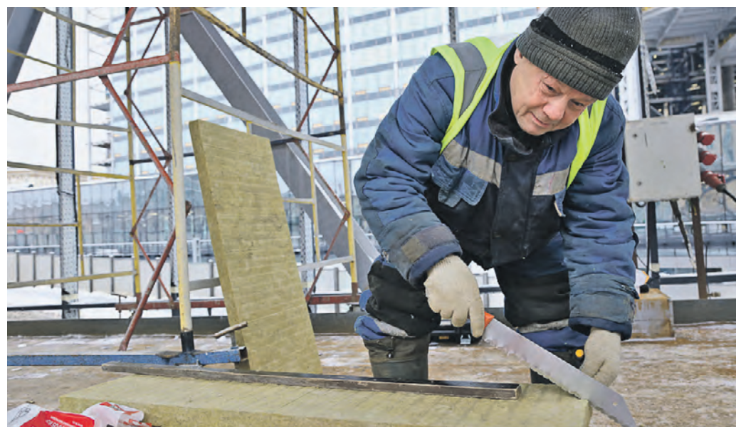
29 января. Разнорабочий Юрий Гордеев занят на утеплении потолка будущего перехода на станции «Кутузовская» на МЦД-4. Фото: Наталья Шатохина
