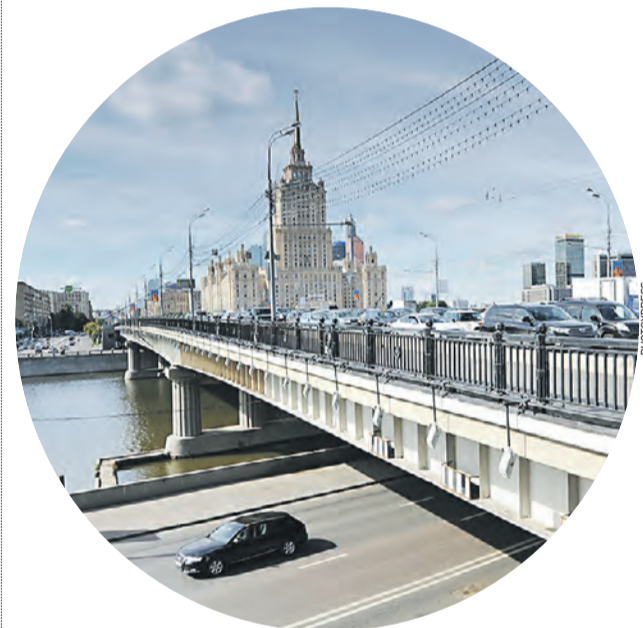
На капитальный ремонт Новорарбатского моста городские власти готовы выделить более 148 миллионов рублей
