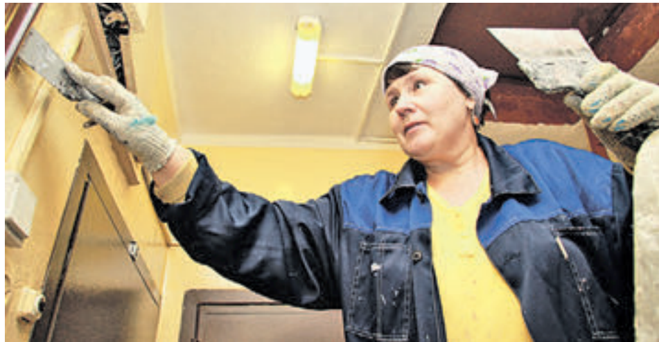
4 декабря 2015 года. Штукатур Наталья Попова проводит капремонт в подъезде жилого дома
