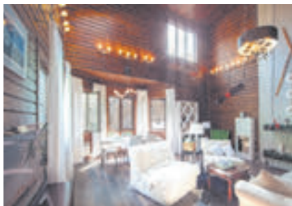
Обшивка стен фальшбрусом
