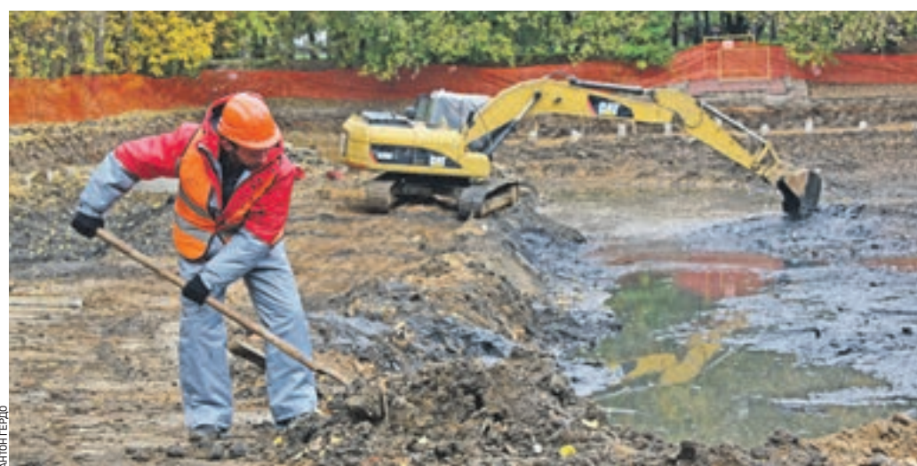
Вчера 13:31 На очистке дна Красногвардейского пруда трудятся рабочие с лопатами, и спецтехника
