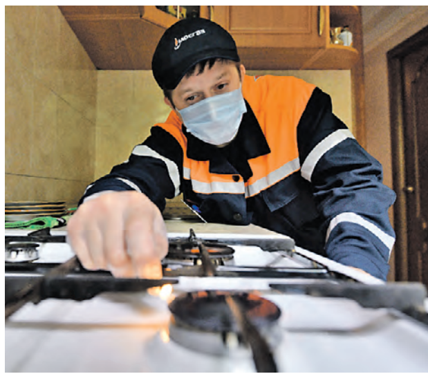
Слесарь Мосгаза Михаил Бульчев проводит плановое техническое обслуживание газовой плиты
