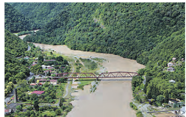
9 июля 2023 года. Последствия дневного ливня в Гагрском районе — дороги превратились в реки
